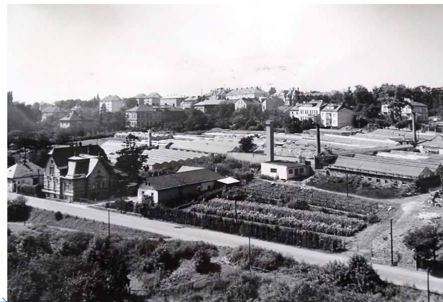
Snímky areálu zahradnictví zhruba z roku 1965 ze střechy Hotelového domu
